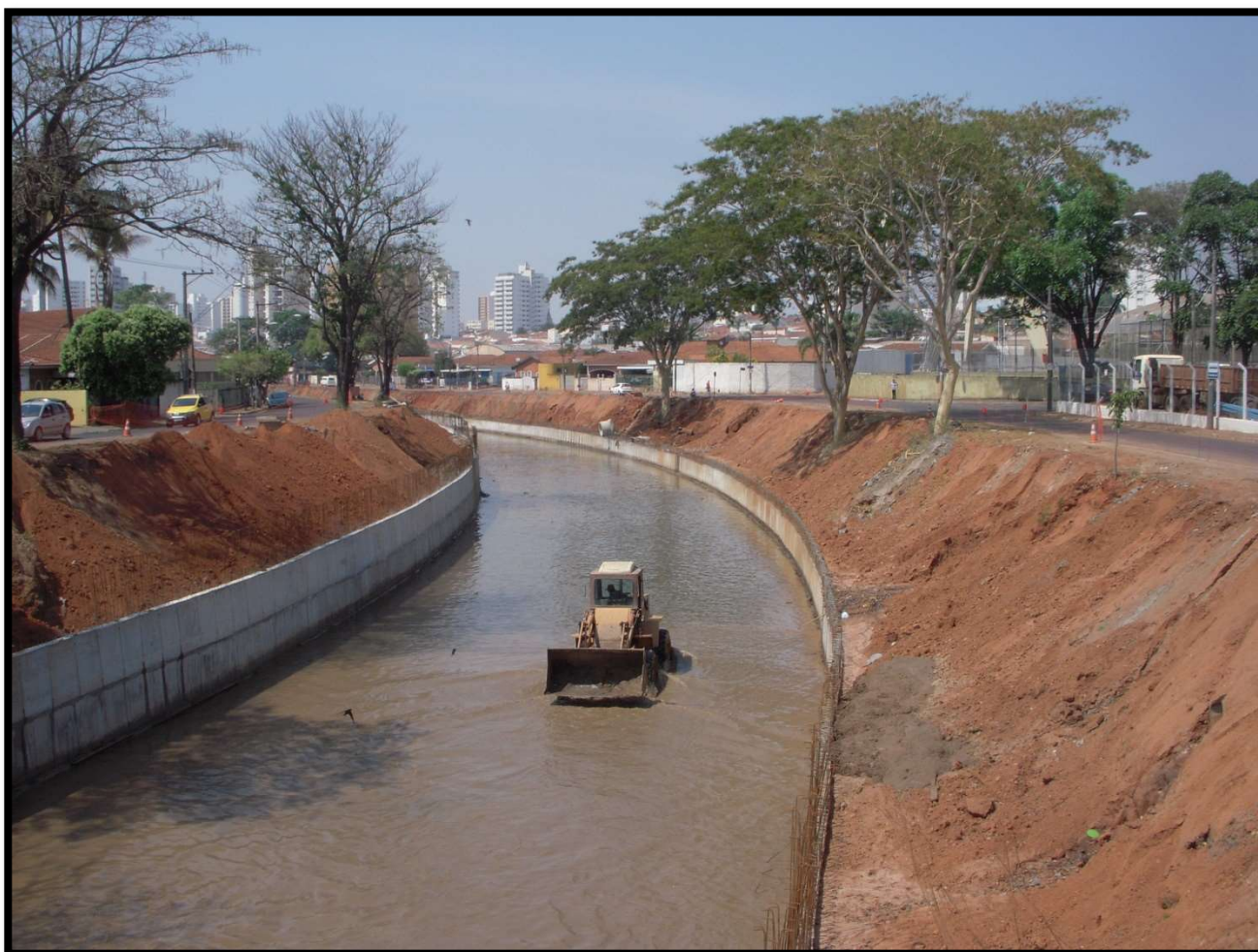
Rio São Domingos – Canal em concreto armado. Aguarda retaludamento
