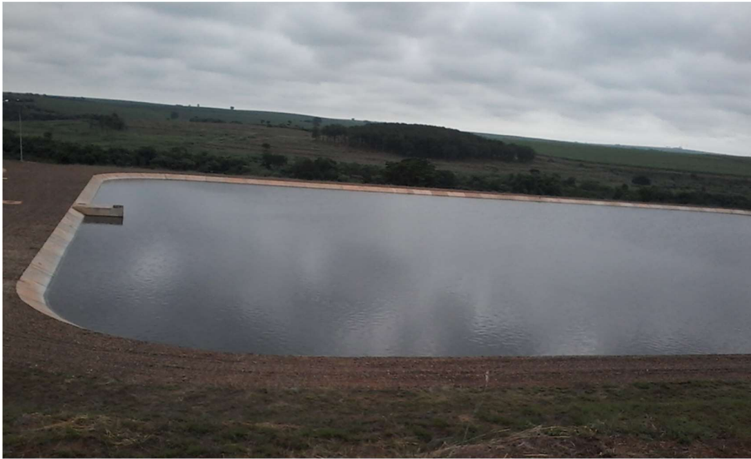
Lagoa de Decantação.
