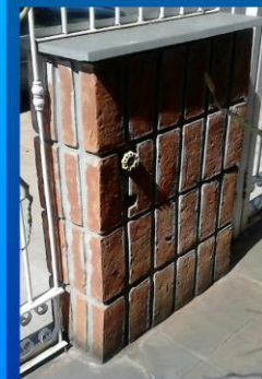
VISÃO TRASEIRA DA CAIXA INSTALADA
