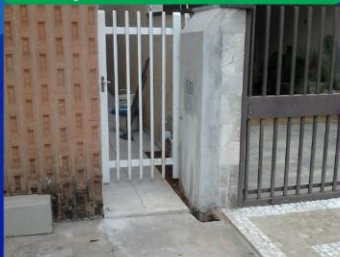
Instalação lateral Recuo de Portão
