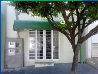
Instalação Alvenaria Externa
