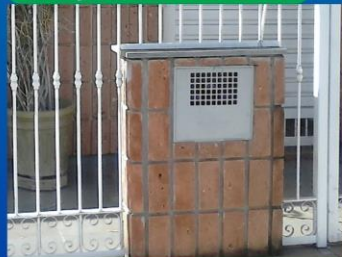
Instalação Alvenaria na Grade
