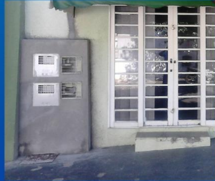
Instalação Alvenaria Externa
