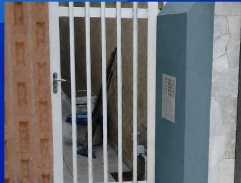
Instalação lateral Recuo de Portão
