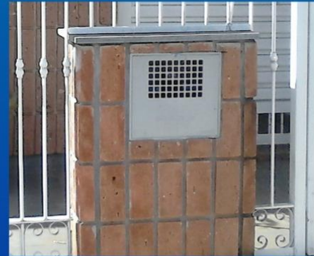
Instalação Alvenaria na Grade
