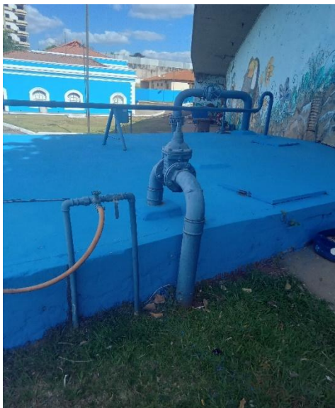
Figura 4-5: Diagnóstico UC1 - Reservatório
