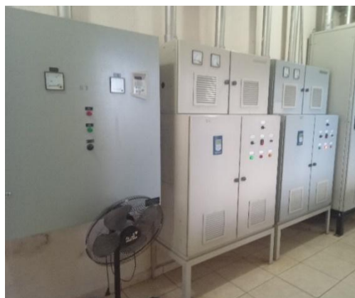
Figura 4-10: Diagnóstico UC1 – Sala de Painéis elétricos
