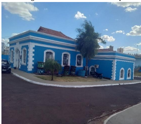
Figura 4-7: Diagnóstico UC1 - Prédio Principal
