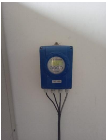
Figura 4-38: Diagnóstico UC4 – Medidor de vazão
