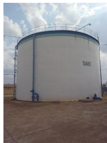
Figura 4-37: Diagnóstico UC4 - Reservatório
