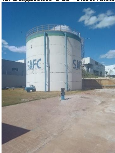
Figura 4-42: Diagnóstico UC5 - Reservatório
