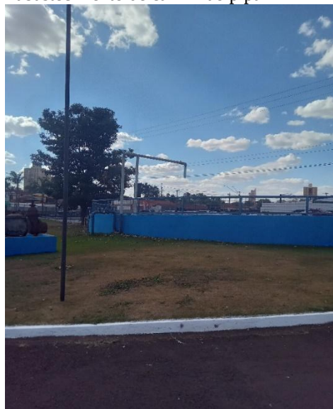
Figura 4-6: Diagnóstico UC1 - Ponto de abastecimento de caminhão pipa
