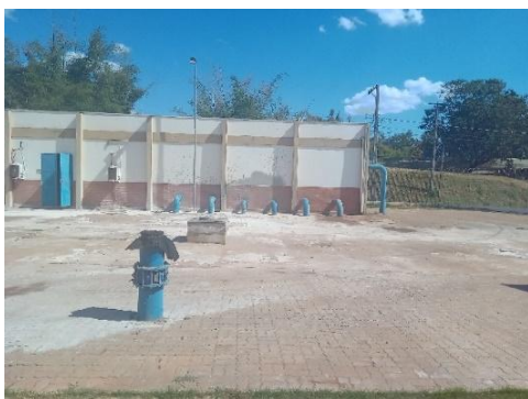
Figura 4-40: Diagnóstico UC5 – Poço desativado
