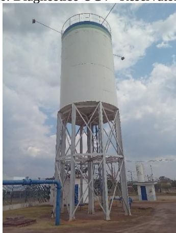
Figura 4-36: Diagnóstico UC4 - Reservatório
