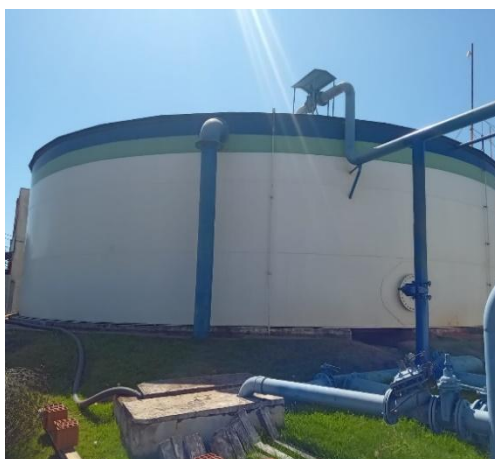
Figura 4-15: Diagnóstico UC2 – Reservatório
