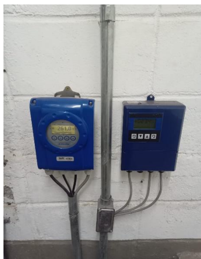
Figura 4-18: Diagnóstico UC2 – Medidores de vazões
