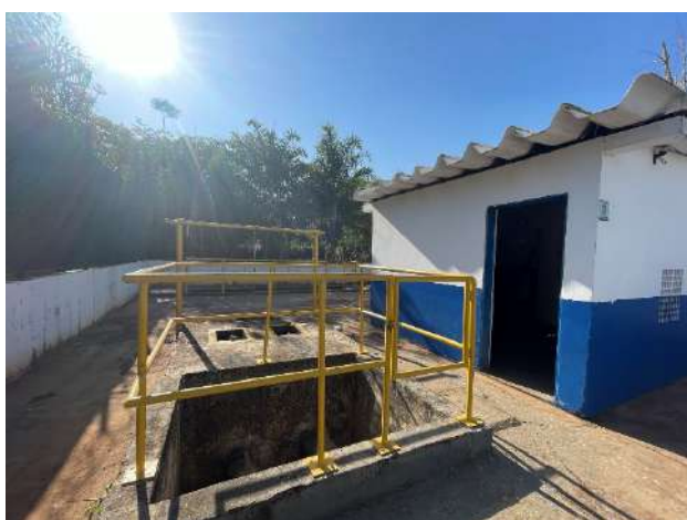
Figura 1.38. Vista externa da EEEB5.
