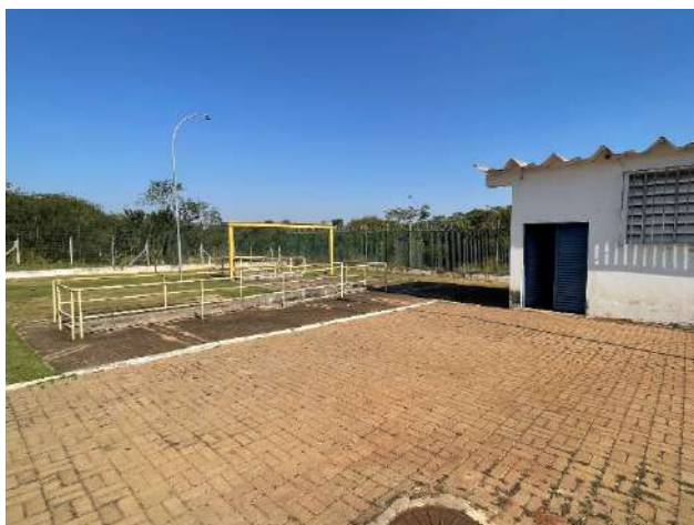
Figura 1.56. Vista externa da EEEB8.
