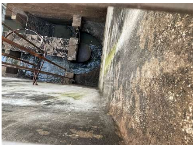
Figura 1.22. Canal com gradeamento e caixa de areia da EEEB2.
