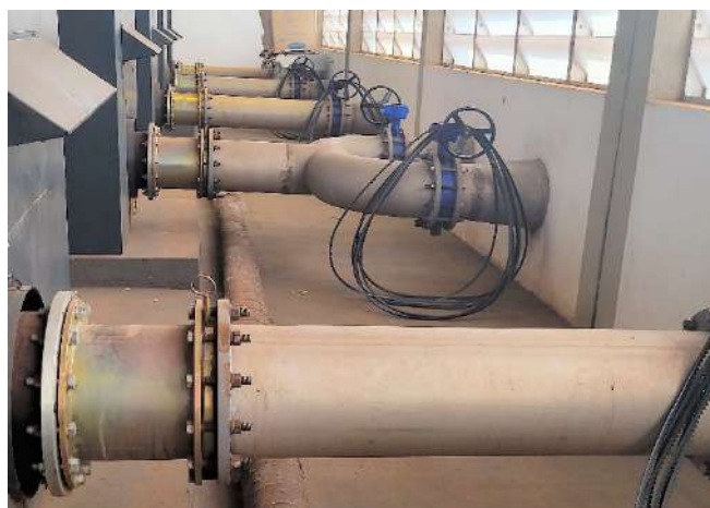
Figura 1.94. Tubulações dos sopradores da ETE.
