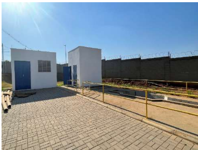
Figura 1.62. Vista externa da EEEB9.
