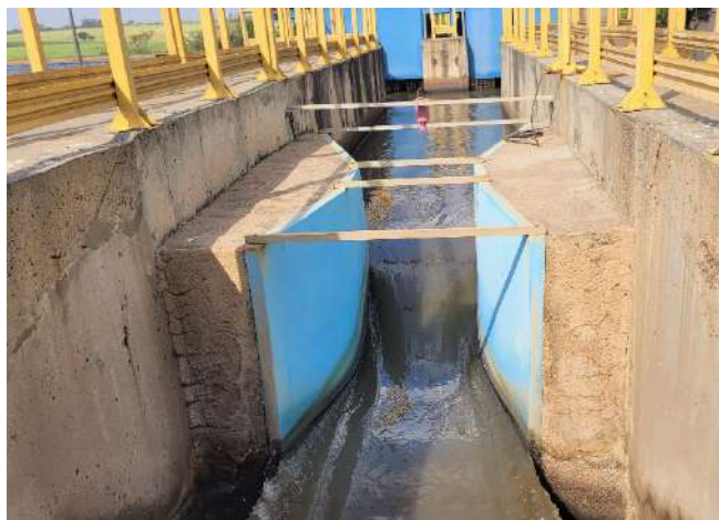
Figura 1.87. lagoas desarenadoras
