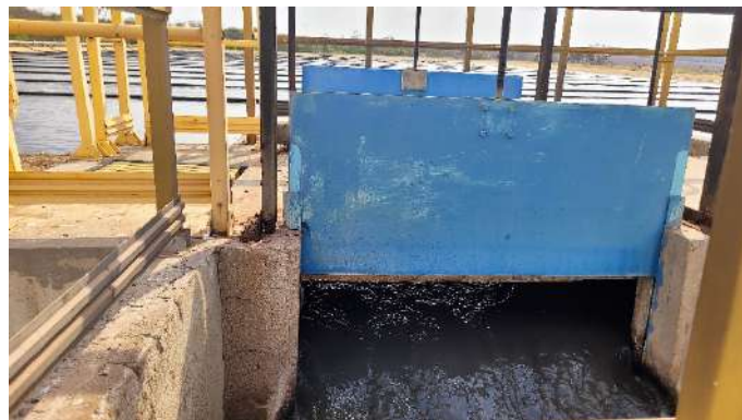
Figura 1.118. Vertedouro - Lagoas Aeradas da ETE – vista 2.
