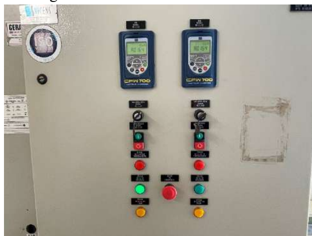
Figura 1.37. Pannel elétrico da EEEB4.
