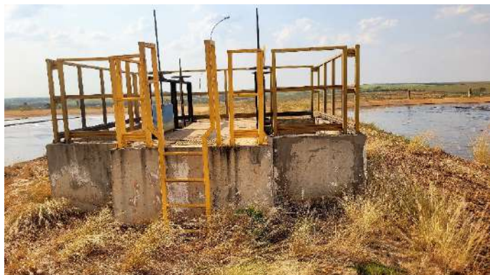
Figura 1.117. Vertedouro - Lagoas Aeradas da ETE – vista 1.
