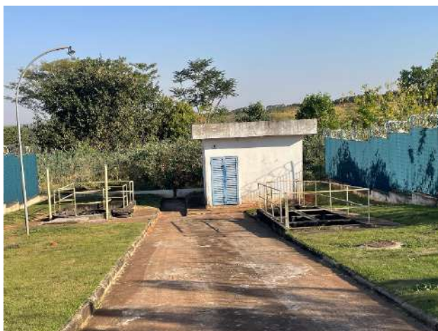
Figura 1.32. Vista externa da EEEB4.
