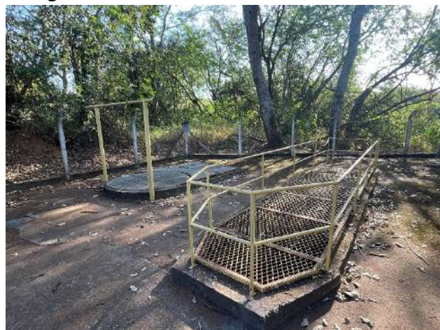
Figura 1.45. Vista das estruturas da EEEB6.
