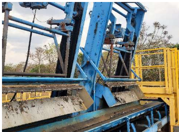
Figura 1.84. Gradeamento mecânico fino do Tratamento Preliminar da ETE.
