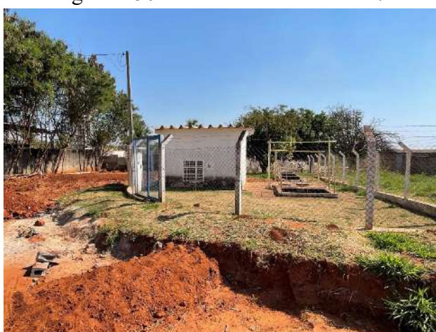
Figura 1.50. Vista externa da EEEB7.
