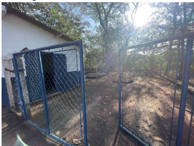
Figura 1.44. Vista externa da EEEB6.
