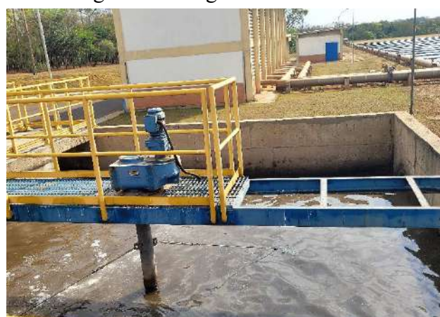
Figura 1.90. Canal da rosca helicoidal
