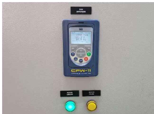
Figura 1.98. Inversor de frequência
