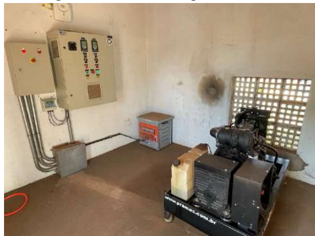
Figura 1.55. Gerador e painel elétrico
