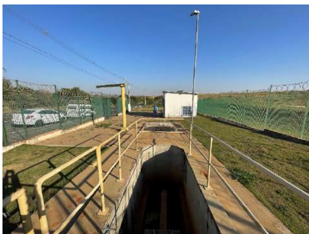
Figura 1.69. Vista externa da EEEB11.
