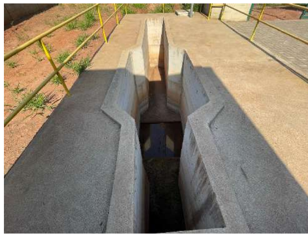
Figura 1.63. Canal com caixa de areia da EEEB9.
