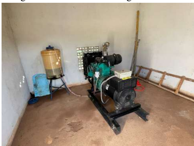
Figura 1.36. Gerador de energia da EEEB4.
