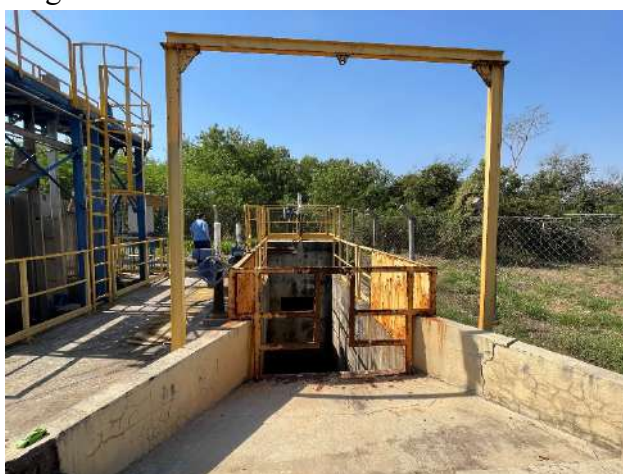
Figura 1.10. Canal com caixa de areia EEEB1.
