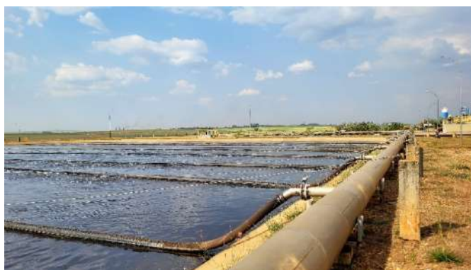
Figura 1.116. Tubulações de ar comprimido - Lagoas Aeradas da ETE.
