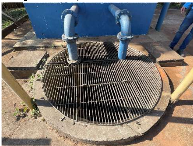
Figura 1.28. Poço volumétrico da EEEB3.
