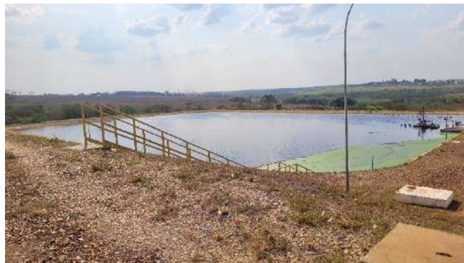
Figura 1.122. Retirada de lodo da lagoa sedimentar da ETE.
