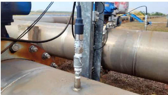
Figura 1.115. Sonda de OD - Lagoas Aeradas da ETE.
