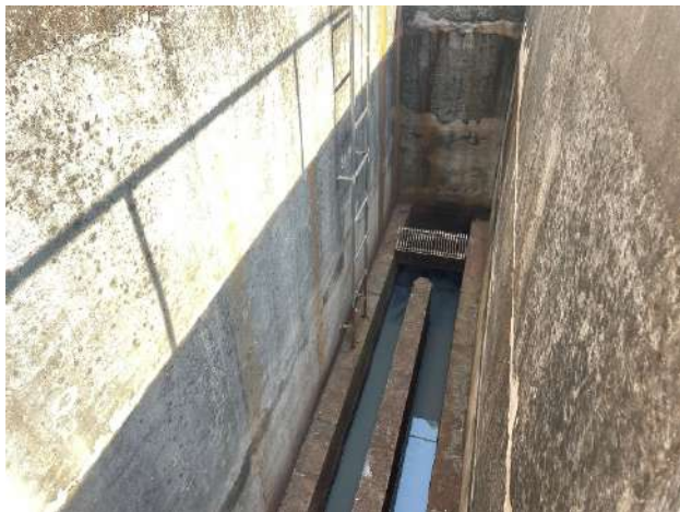
Figura 1.54. Poço volumétrico
