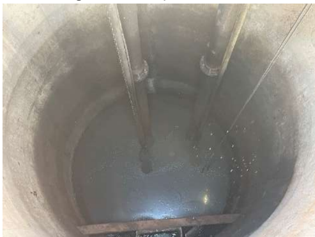
Figura 1.54. Poço volumétrico
