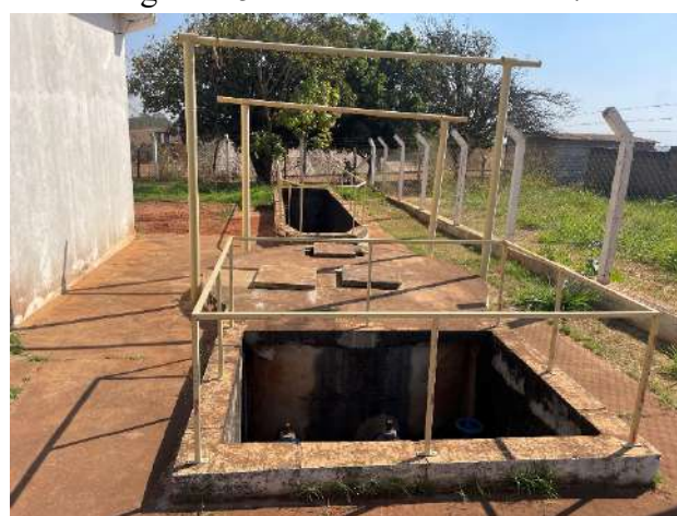
Figura 1.51. Estruturas da EEEB7.
