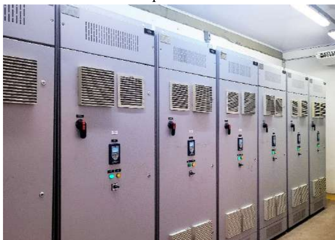
Figura 1.97. Painéis elétricos de controle dos sopradores
